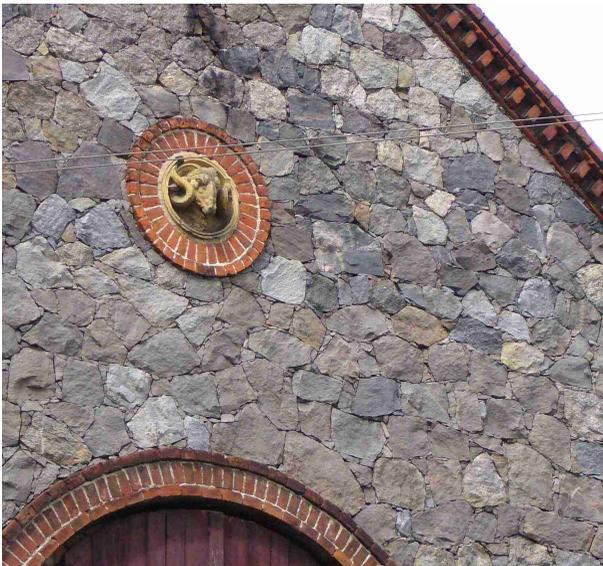
Abb. 4: Detail des Zwickelmauerwerks in Wolfshagen.
